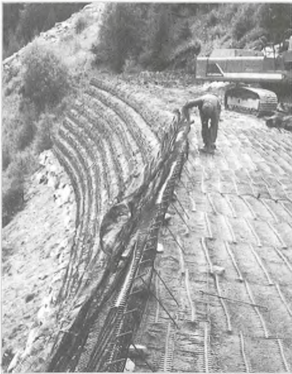
Schutzdamm Köflberg im Bau
