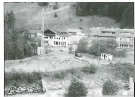
Klärbecken Gisse in Bau
