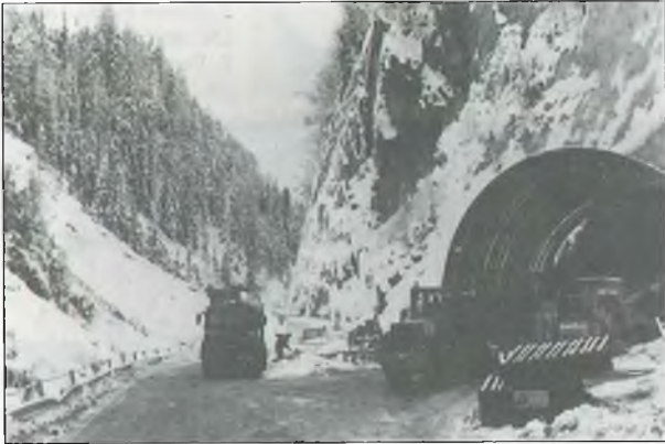
Der Tunnel. Die Arbeiten in der Klamme schreiten jetzt recht zügig voran. Auf dem Bild die Nordeinfahrt des Tunnels
