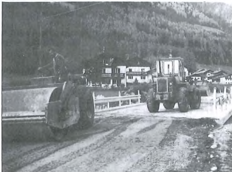
Neubau der Brücke - Arbeiter in vollem Einsatz
