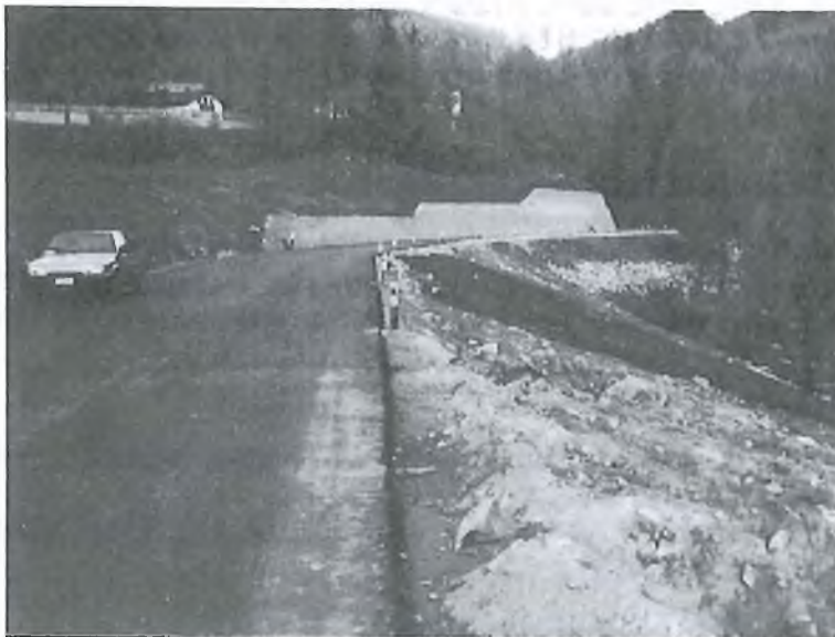
Ausbau der Straße in St. Peter (1986)
