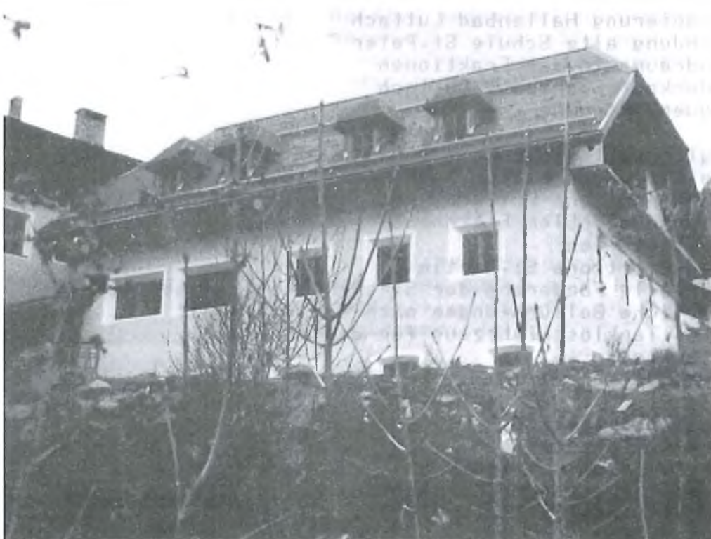
Der Bau der Schnitzschule St. Jakob geht 1986 zügig weiter
