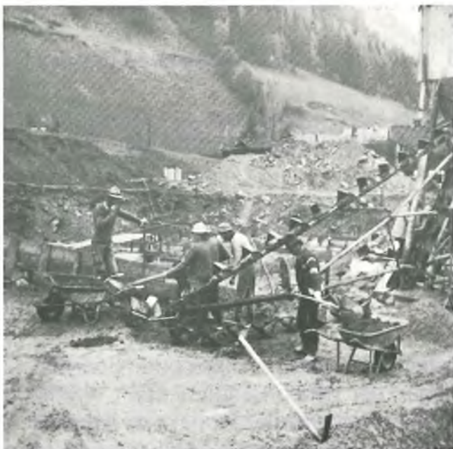
Grundmauern für die neue Volksschule in Steinhaus
