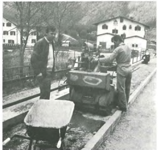
Bau des Gehsteiges Gisse
