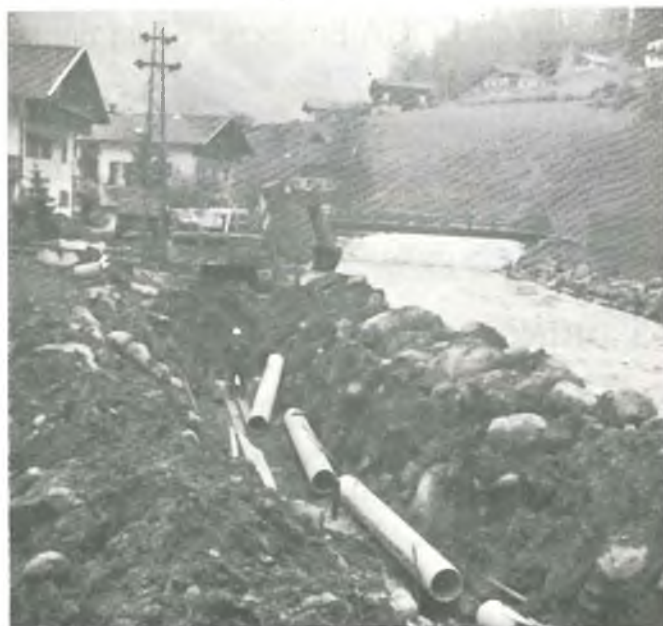
Kanalisierungsbau St. Johann
