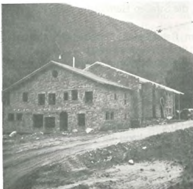
Bau der neuen Volksschule Steinhaus
