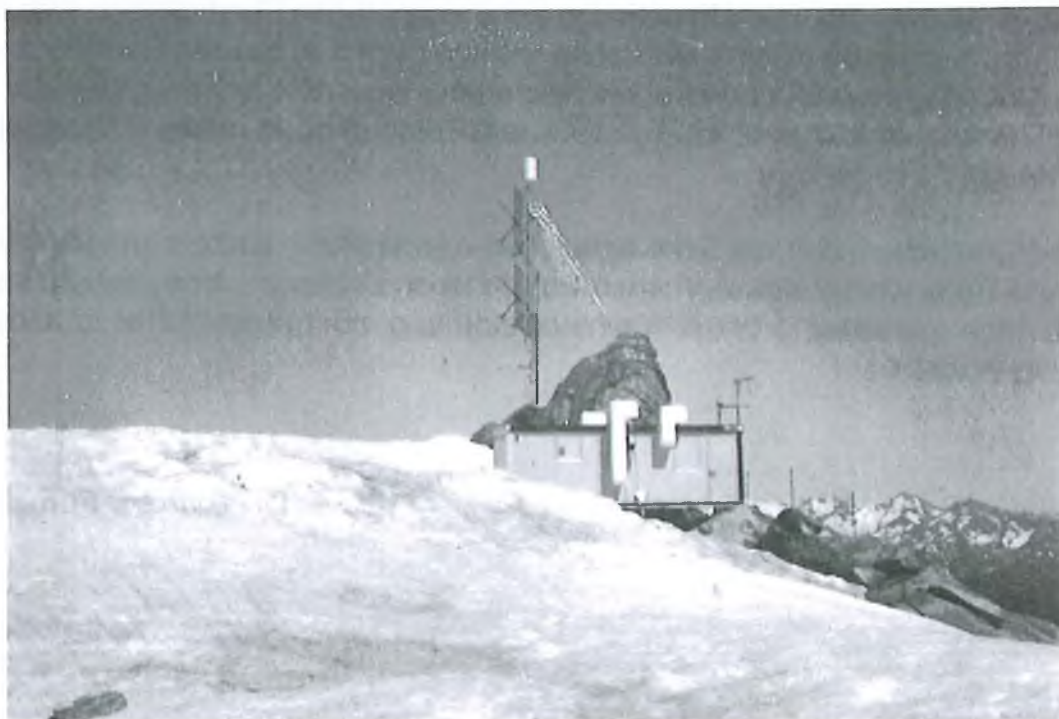
Die errichtete Anlage, vom Schwarzenstein aus aufgenommen.
