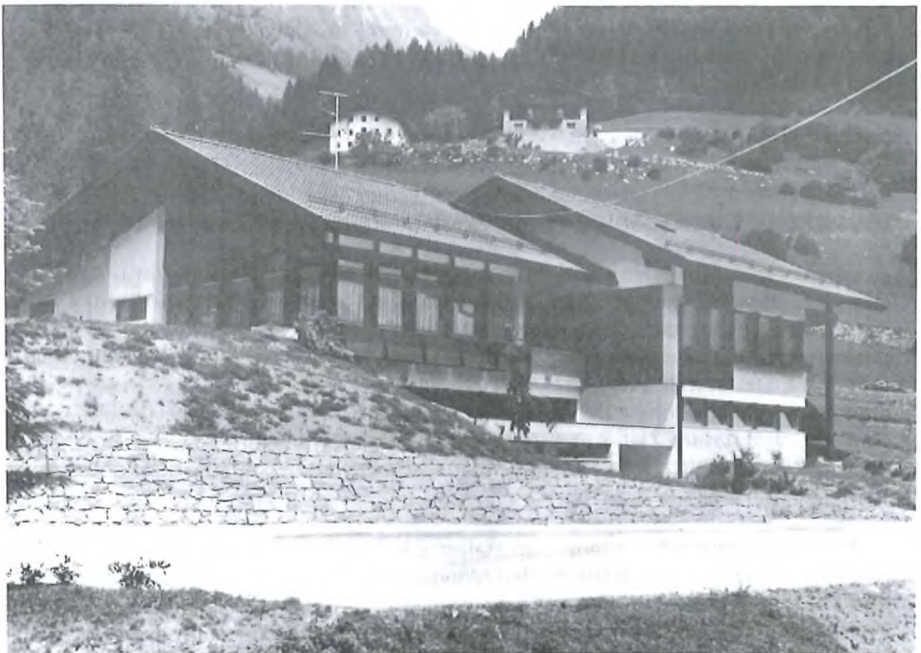
Der neue Kindergarten mit Vereinshaus in Steinhaus ist gut gelungen und wird auch gut genutzt.
