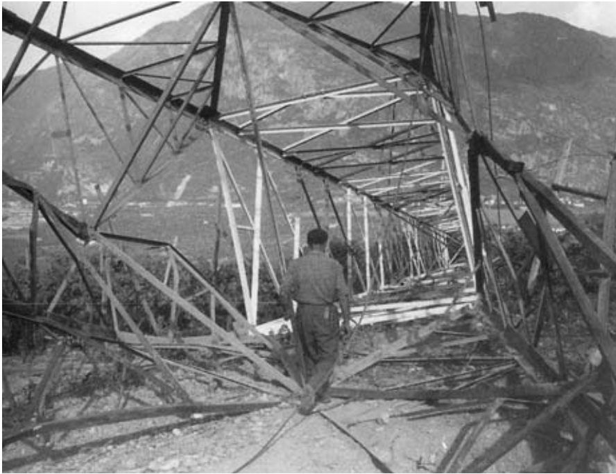
Ziel der Anschläge waren vorwiegend die Masten der Hochspannungsleitungen auch im Tauferer Tal
