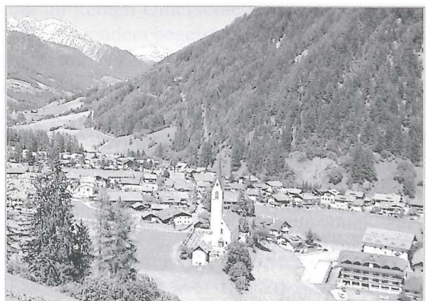
Die Erweiterung des Friedhofes und die Sanierung des Ahrntaler Hallenbades werden die großen Herausforderungen für die nächste Verwaltungsperiode in Luttach sein
