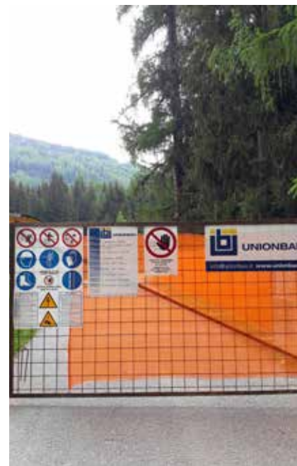
Mehrzweckhalle (Turnhalle) Luttach Baubeginn am 2. Mai 2018
