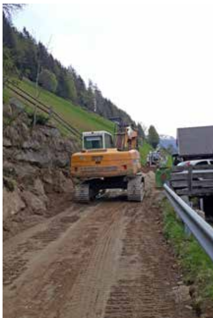
In St. Jakob wurden die Arbeiten bei der Löschwasserleitung „Am Bergl“ wieder aufgenommen
