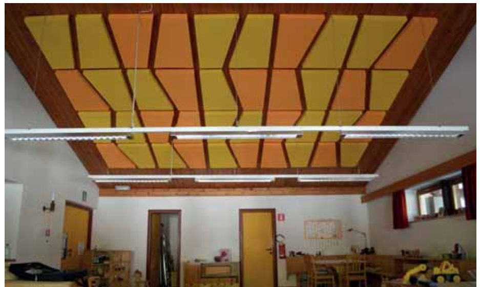
Akustische Sanierung im Kindergarten Steinhaus
