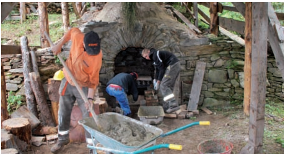
Der mit Steinen gefüllte Ofen wird für den Brand zugemauert. Nur das Schürloch bleibt offen.
