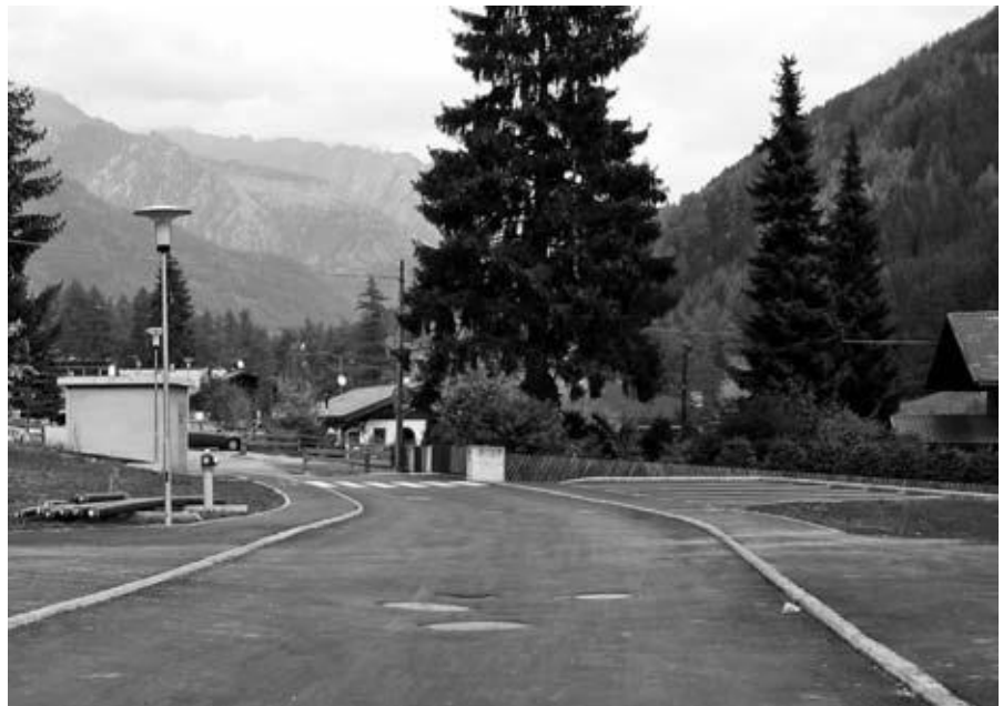
Gehsteig in der Zone Lichtegg
