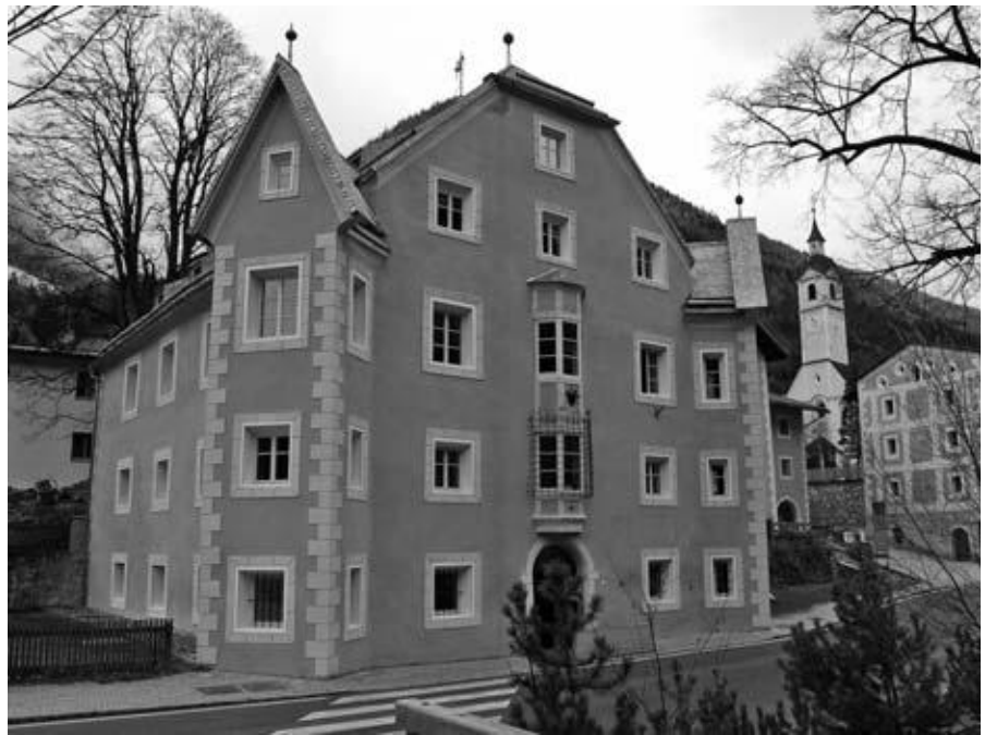
Die Restaurierungsarbeiten am Rathaus in Steinhaus sind fertiggestellt
