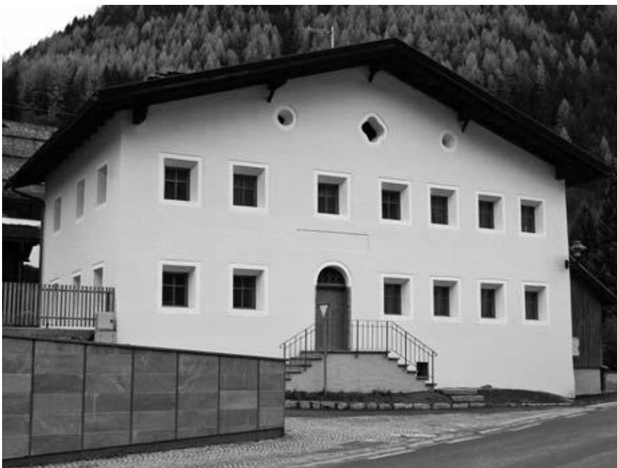
Altenwohnungen in der Schule von Steinhaus
