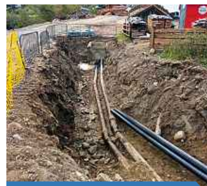
Steinhaus, Verlegung der Wasserleitung Bereich Kundler
