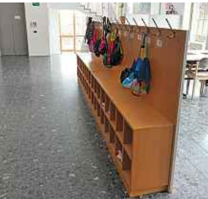
Grundschule St. Johann, Umbau der Garderobe
