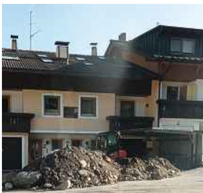
Luttach, Reparatur an Wasserleitung
