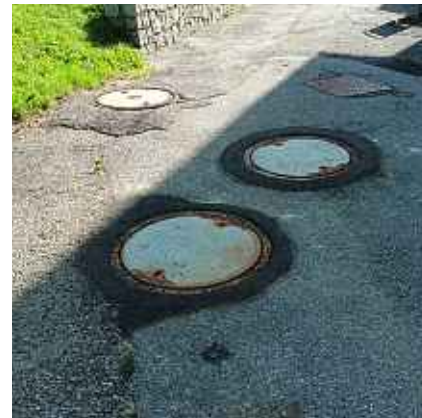
Steinhaus, Reparatur bei Schächten
