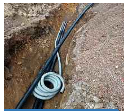
Steinhaus, Verlegung der Wasserleitung Bereich Kundler
